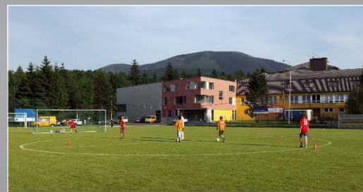
Přístavba tělocvičny Čeladná, 2010
